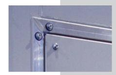
**Sheet metal door frame,** not thermal broken.
